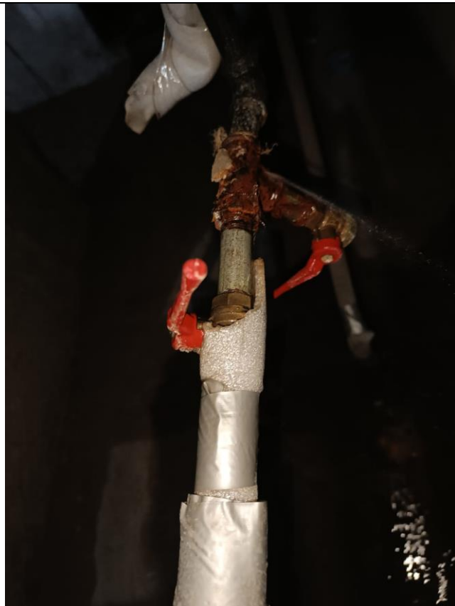
Фото 7 – Наличие течи в резьбовом соединении
