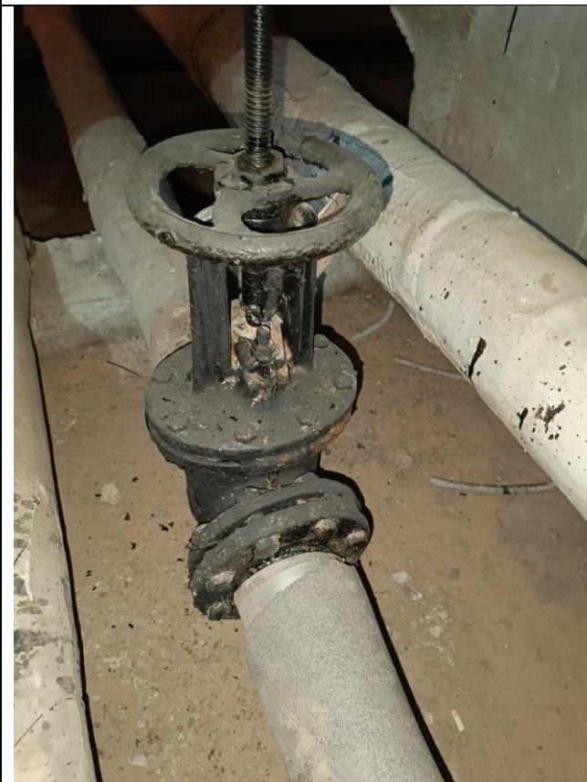
Фото 19 – Запорно-регулирующая арматура
