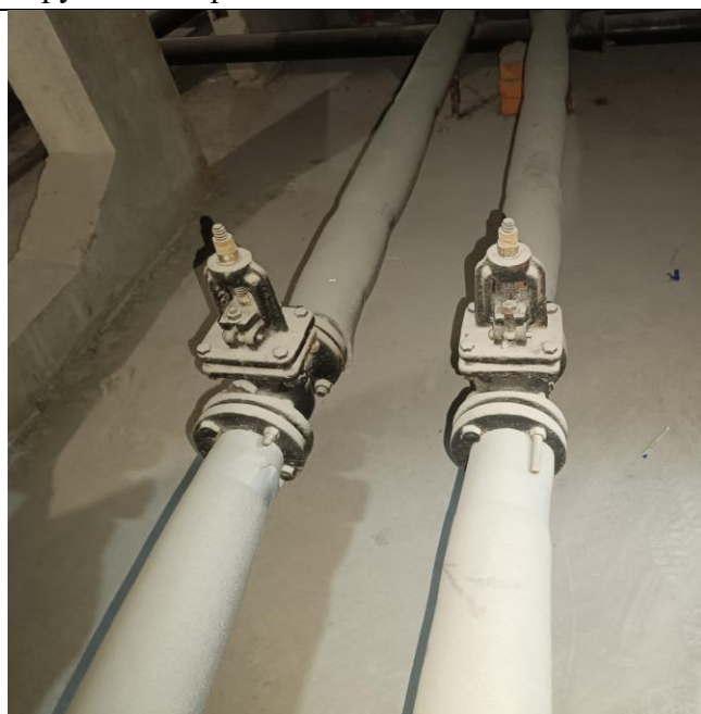
Фото 21 – Запорно-регулирующая арматура находится в ограниченно-работоспособном состоянии не обеспечивать полное закрытие подачи воды
