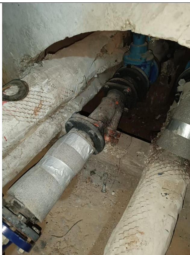
Фото 23 – Имеются течи во фланцевых соединениях
