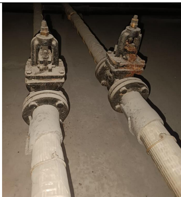
Фото 22 – Запорно-регулирующая арматура находится в ограниченно-работоспособном состоянии не обеспечивать полное закрытие подачи воды
