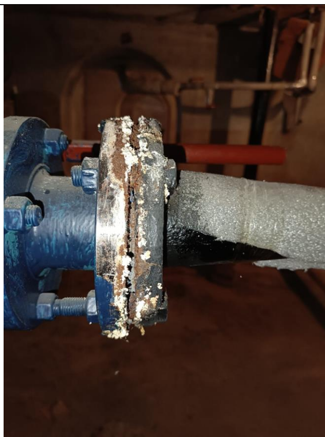
Фото 24 – Имеются течи во фланцевых соединениях
